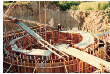
発電所建設工事
