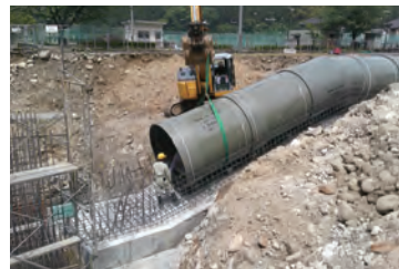
水圧管路敷設作業
