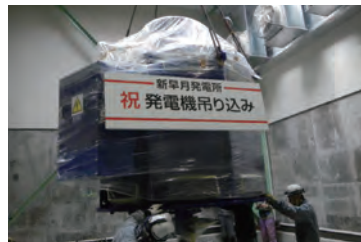
発電機吊り込み作業
